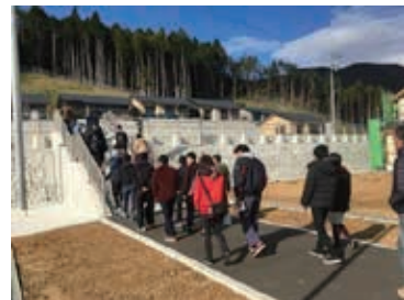
かさ上げ工事
